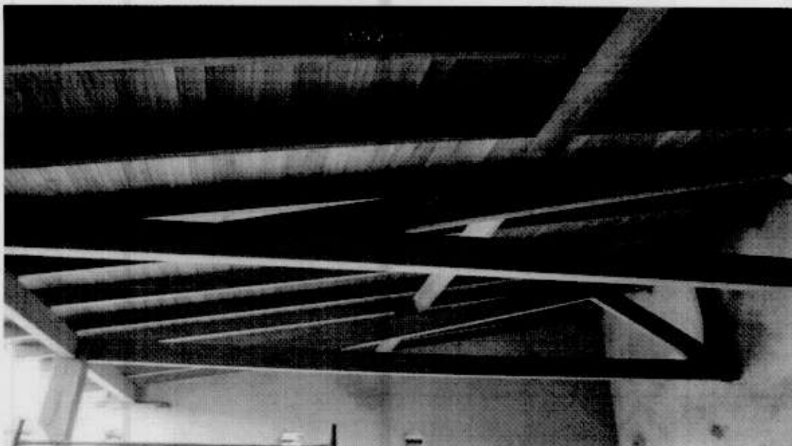
Fig 2: Aspecto final do madeiramento da cobertura.
