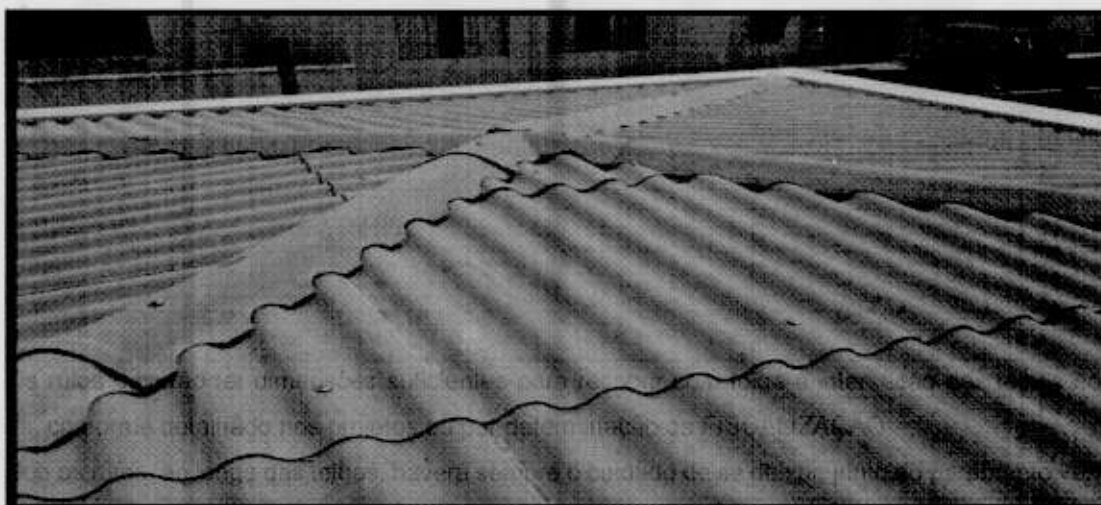
Fig 1: Telhamento em telhas onduladas de fibrocimento 6 mm.
